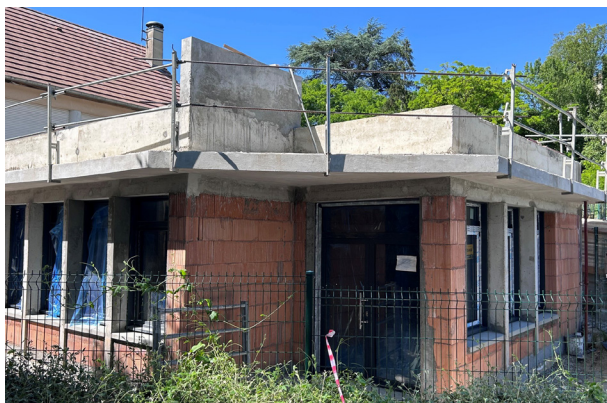
La future cantine scolaire prend forme avec l'installation des fenêtres.
