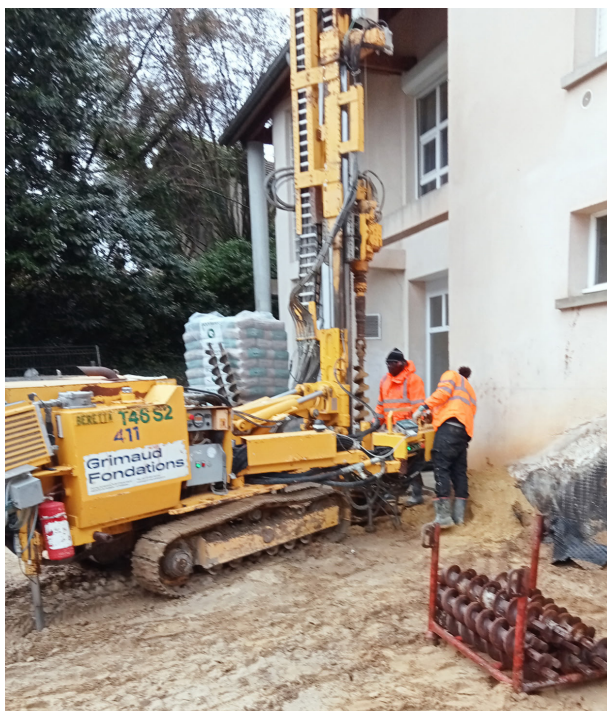
Début février, une foreuse spéciale a permis l'insertion des micropieux sur le terrain sablonneux.
