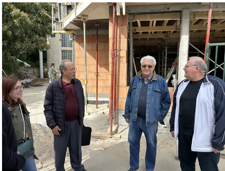
Chaque lundi, élus, architecte et entreprises pour traiter les problématiques du chantier.
